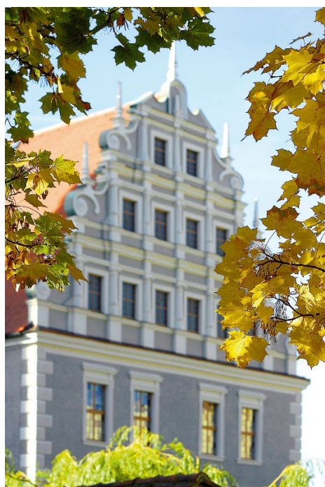
Der Heffterbau in Zittau Foto Rene E. Pech
